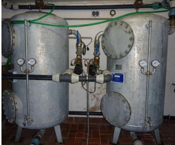
Die Filterkessel werden jede Nacht automatisch rückgespült.
